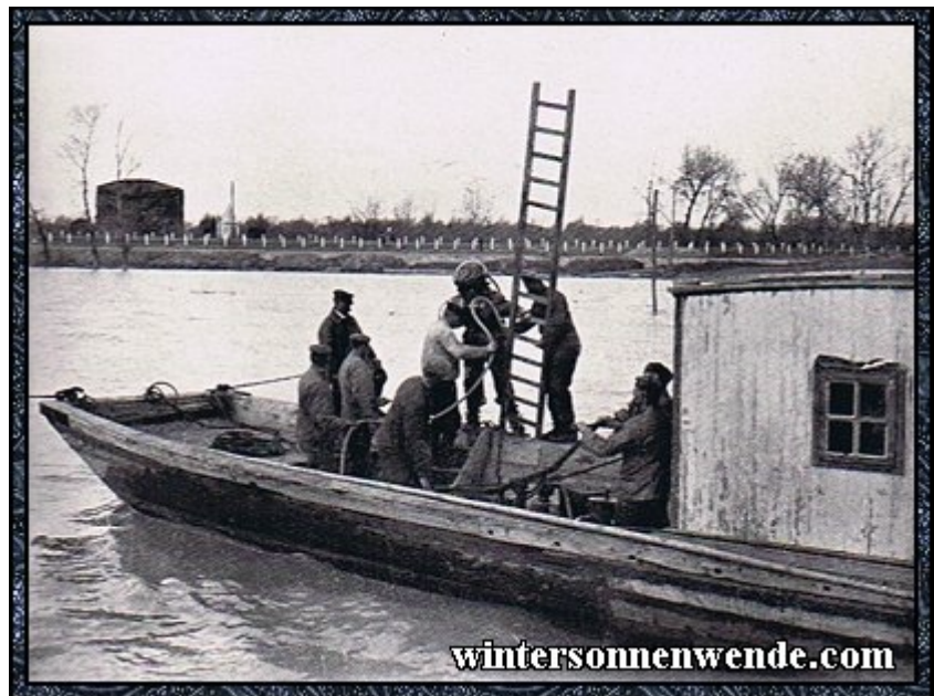
Taucher bei Hebearbeiten an versenkten Donauschiffen.
