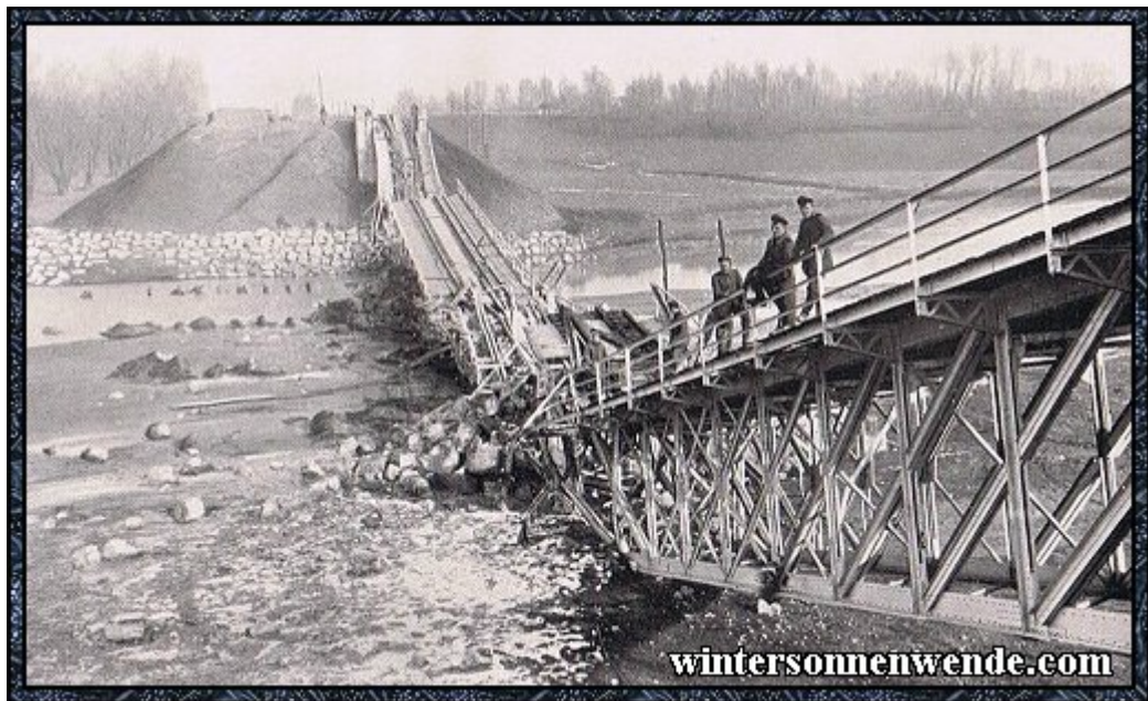
Feldzug gegen Rumänien 1916. Von den Rumänen gesprengte Eisenbahnbrücke über die Putna flüchtig benutzbar gemacht.
