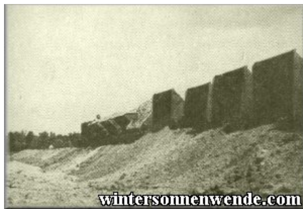
Bau eines Dammes gegen Überschwemmungen.
