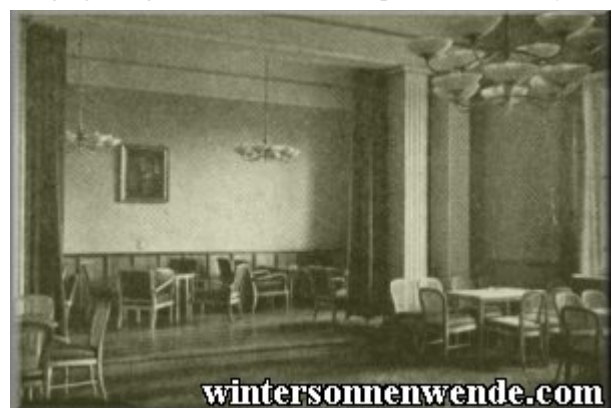
Speisesaal im Kasino des Kreishauptmanns in Grojec.
