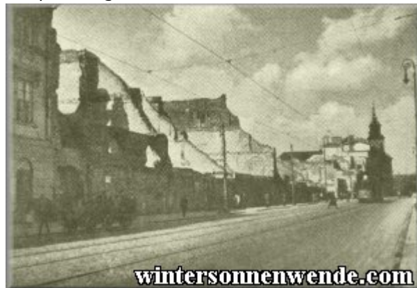
Strasse in Warschau nach den Aufräumungsarbeiten.
