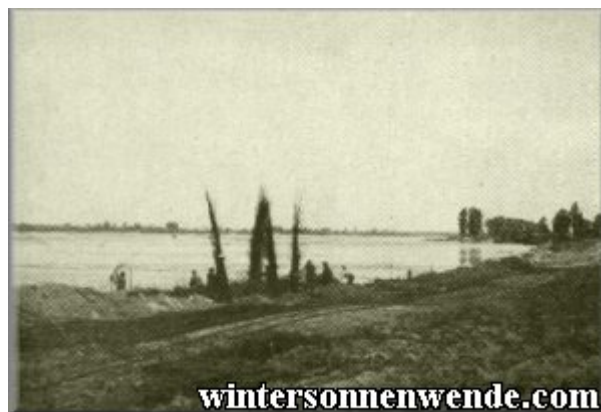
Deichbau an der Weichsel.
