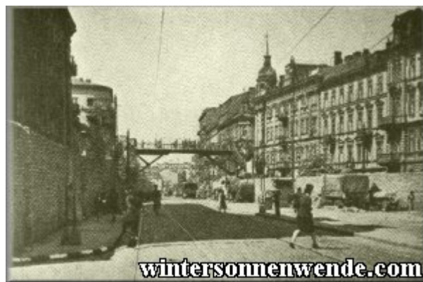
Verbindungsbrücke zwischen Nord- und Südteil des jüdischen Wohnbezirks.
