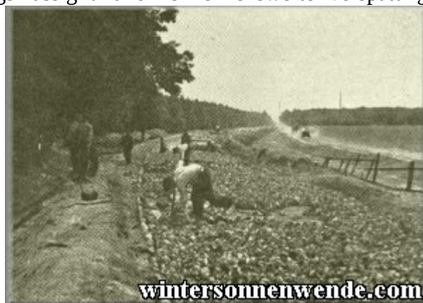
Neubau einer Strasse bei Warschau.
