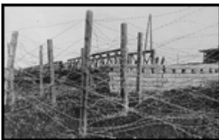
Starke russische Befestigungen an einer Eisenbahnbrücke.
