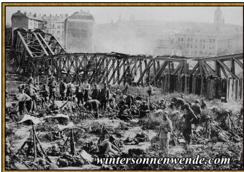
An der gesprengten San-Brücke.
