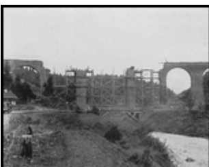
Der von k. u. k. Eisenbahnern wiederhergestellte Lubicna-Viadukt bei Delatin.
