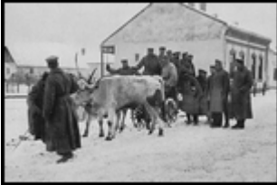
Zwischen den Schlachten: Neuer Proviant.
