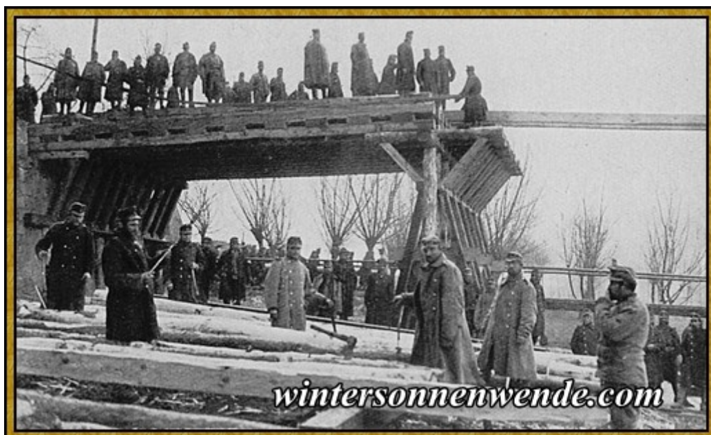
beim Wiederherstellen gesprengter Brücken.
