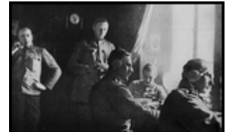
Telephonzentrale im Stabsquartier.
