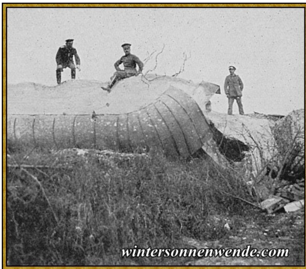
Die Wirkung der Mörser von Krupp und Skoda an einem Panzerturm auf Fort 11: Die Kuppel eines Geschützturmes, die 30m weggeschleudert wurde.
