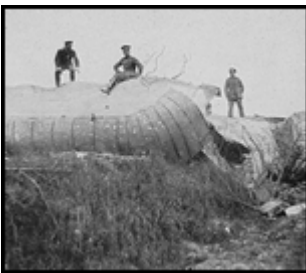
Die Kuppel eines Geschützturmes, die 30m weggeschleudert wurde.
