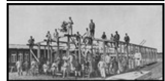
Bau der zweiten Lazarettbaracke im Lager Wasbek.
