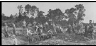
Beim Grabenbau, Wasbek.
