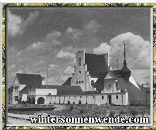
Der Bahnhof von Gdingen. (Original S. 272.)
