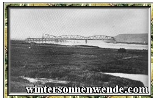
Stand der Abbruchsarbeiten am 28. August 1929.
