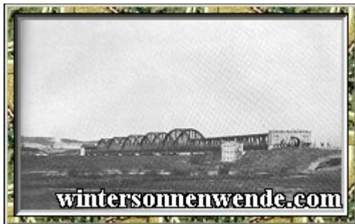
Die Abrißarbeiten beginnen.
