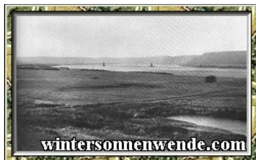
Die Pfeiler der Brücke vor der Sprengung.
