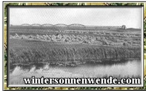
Der gewaltige Bau vor dem Abbruch, aufgenommen am 20. August 1927.
