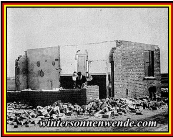
Deutsche Ostnot: Zerfallende Bahnwärterhäuser. Photo Scherl.
