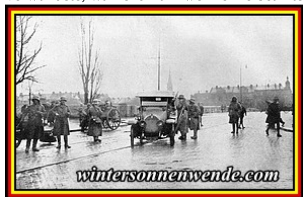
9. November 1923: Abgesperrte Isarbrücke in München. Photo Scherl.
