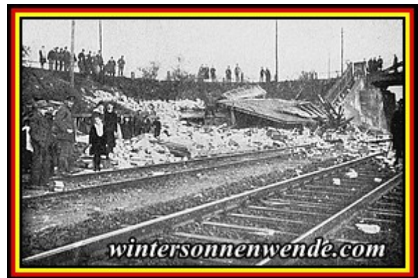
1921: Von Kommunisten gesprengtes Stellwerk bei Ammendorf. [Photo Scherl?]
