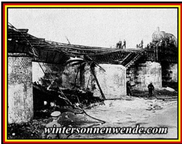
Oberschlesien 1921: von Insurgenten gesprengte Eisenbahnbrücke bei Szczepanowitz–Oppeln. Atlantic-Photo.
