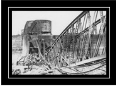
Gesprengte russische Haupt-Verkehrsbrücke über den Dnjestr.
