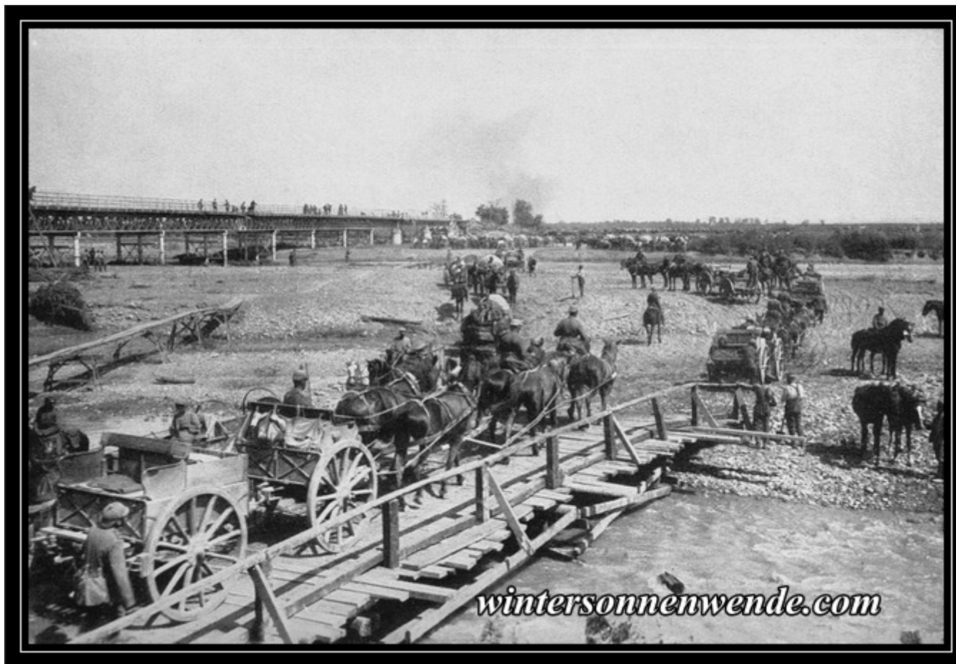
Das charakteristische Bild von Truppenübersetzungen auf einfachen Bohlenbrücken, die als Ersatz für die gesprengten Hauptbrücken dienten.
