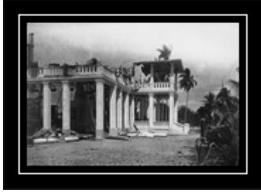
Das von den Engländern zerschossene Gouvernementsgebäude in Daressalam.
