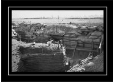
Freiwillig geräumte, gut ausgebaute russische Stellung bei Grodno.
