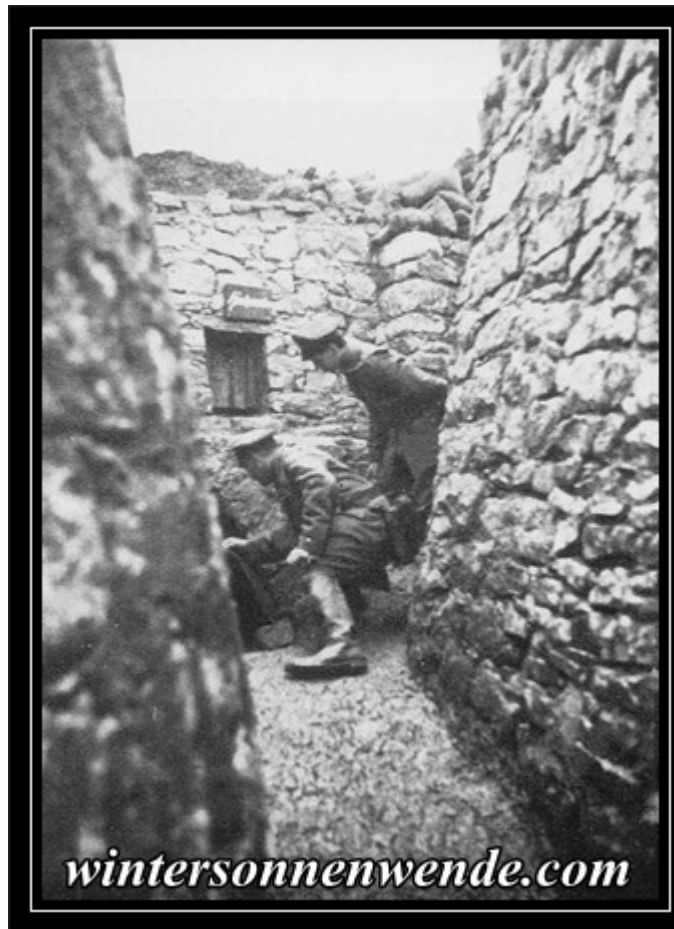
Stark ausgebauter Graben in vorderster Linie auf der Ailly-Höhe, mit 50 cm tiefen Steinstützmauern; bestbewährte Bauart. Blick in den tiefen Stolleneingang, welcher zwecks Abhörung und Sprengung bis vor zum Feinde reicht.
