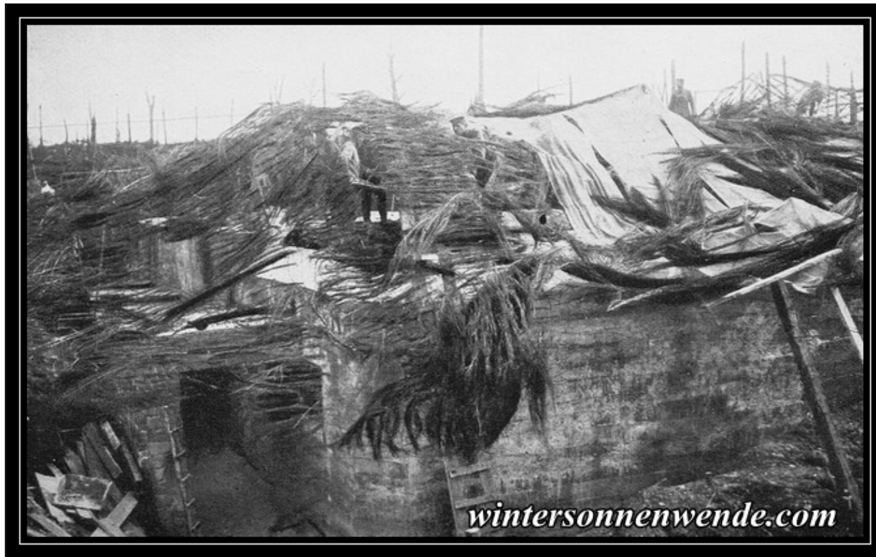
Gegen Fliegersicht gedeckter und gegen Feuerüberfall gesicherter Gefechtsstand eines Abschnittskommandeurs.
