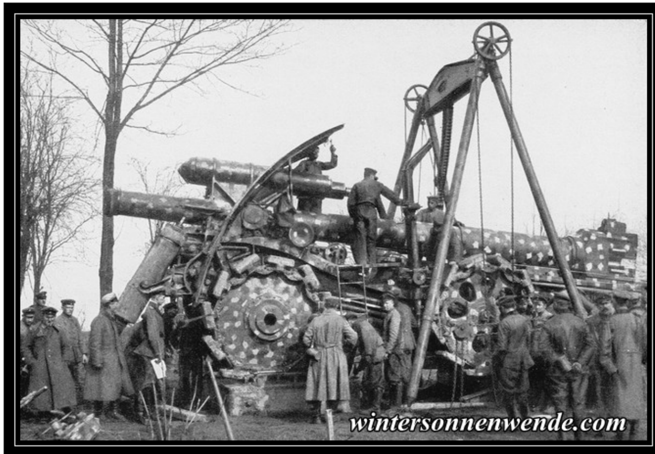
Schwere 15-cm-Langrohrkanone wird vom Rohrwagen mit Hilfe eines Hebekrans auf die Lafette gehoben.
