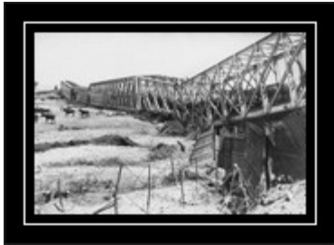
Gesprengte russische Eisenbahnbrücke bei Hzebenör.
