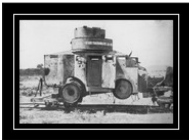
Ein Panzerwagen wird auf der Feldbahn zur Instandsetzung rückbefördert.
