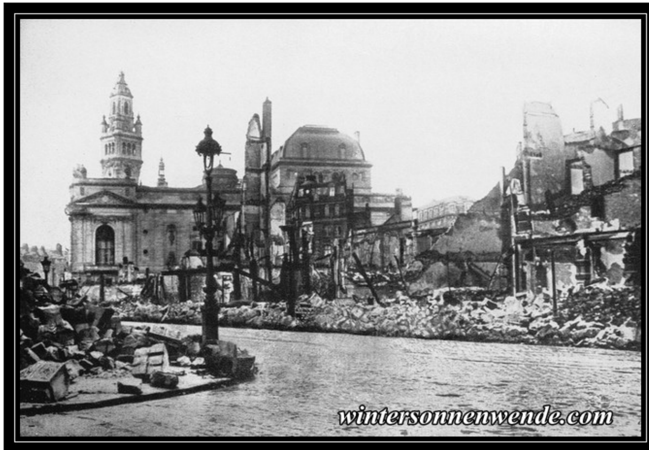
Zerstörtes Stadtviertel von Lille in der Nähe des Stadttheaters und des Rathauses, die beide verschont blieben. Lille, eine Stadt mit über 200 000 Einwohnern in Nordfrankreich, wurde am 13. Oktober 1914 nach hartnäckigem Widerstand besetzt.
