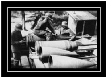
Montieren der 18 Zentner schweren Riesengeschosse.
