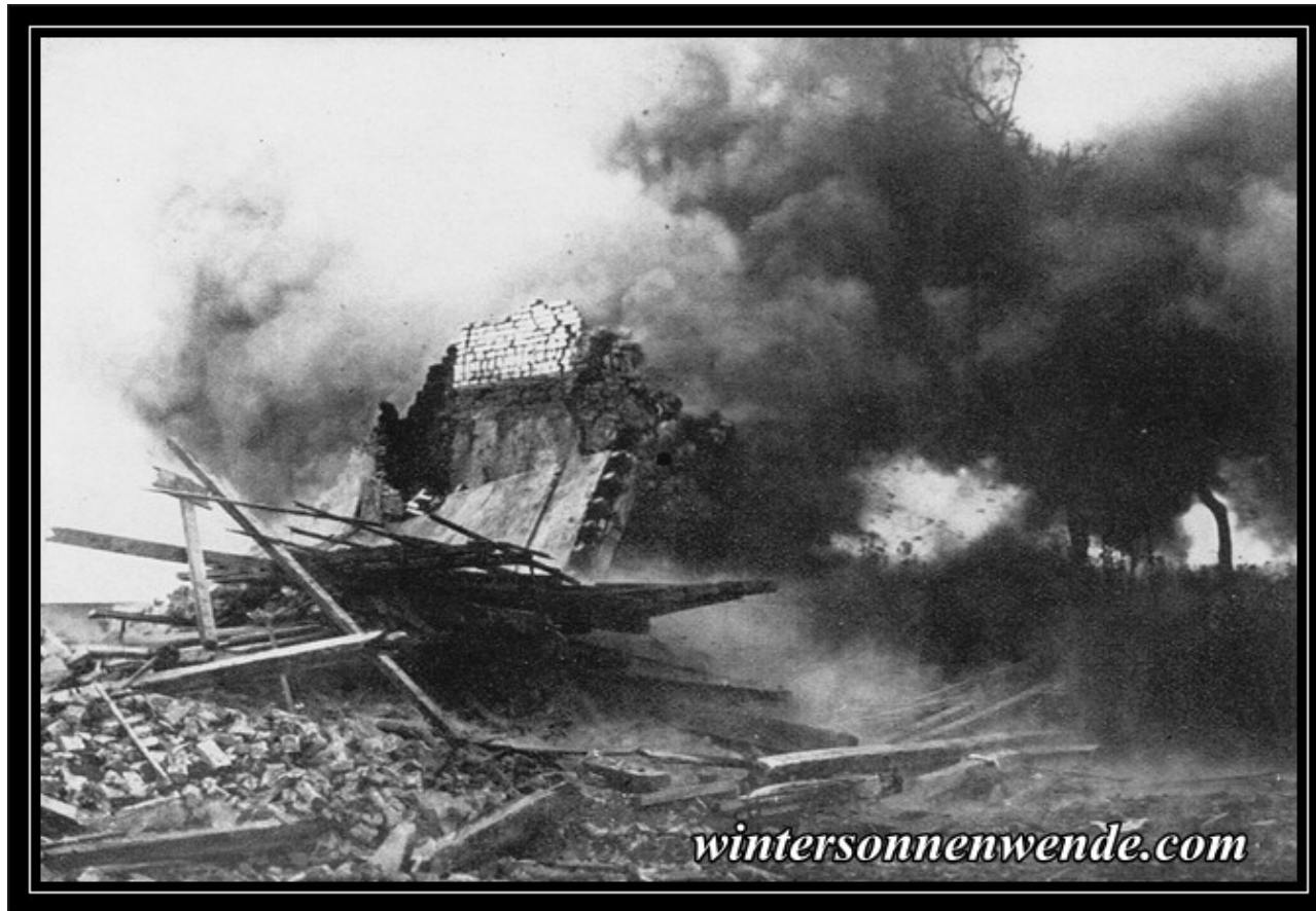
Einschlagen einer englischen 38-cm-Granate in ein Wohngebäude bei Bapaume (Somme) . Durch die gewaltige Explosion stürzte das ganze Gebäude in sich zusammen.
