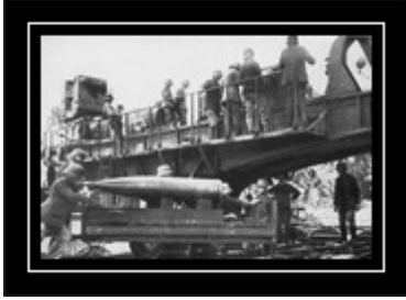
Heranfahren der fertigen 38-cm-Geschosse.
