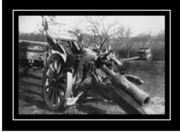
Ein schwerer Rohrkrepieler.
