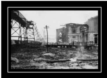
Der zerstörte Bahnhof von Haidar-Pascha (Skutari).
