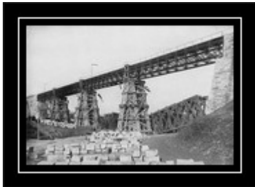
Die wiederhergestellte Eisenbahnbrücke bei Pluhów.
