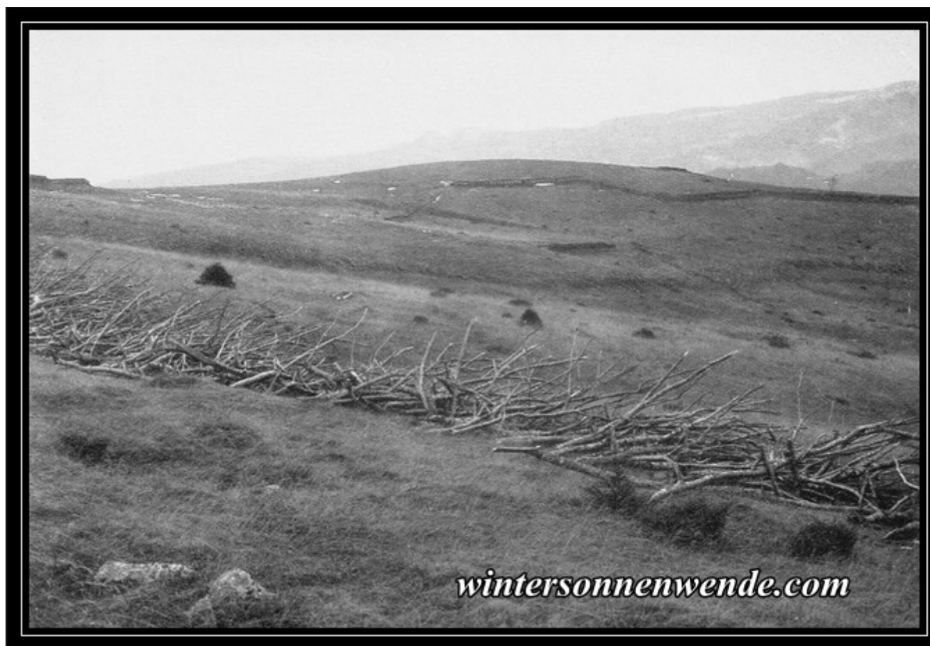
Behelfsmäßiges Hindernis aus Buchen-Ästen als Ersatz für den sonst so bewährten Drahtverhau vor den rumänischen Stellungen am Törzburger Paß.
