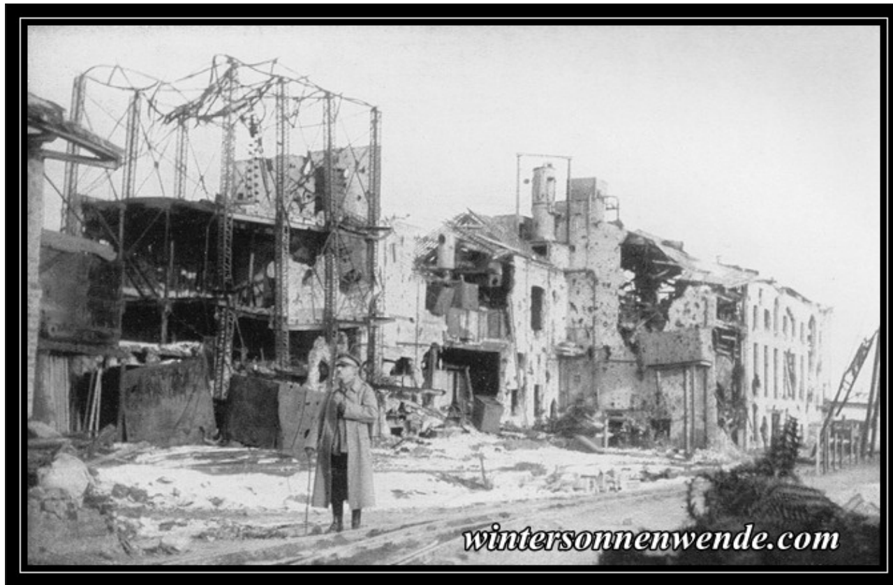
Die zerstörte große Zuckerfabrik bei Deulemont-Quesnoy.
