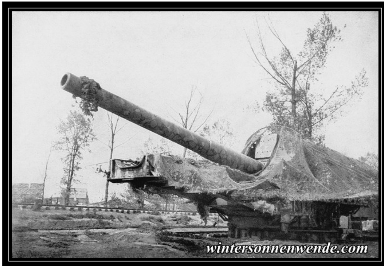
Deutsche 38-cm-Langrohr-Schnelladekanone in verdeckter Stellung bei Bapaume. Juni 1918.
