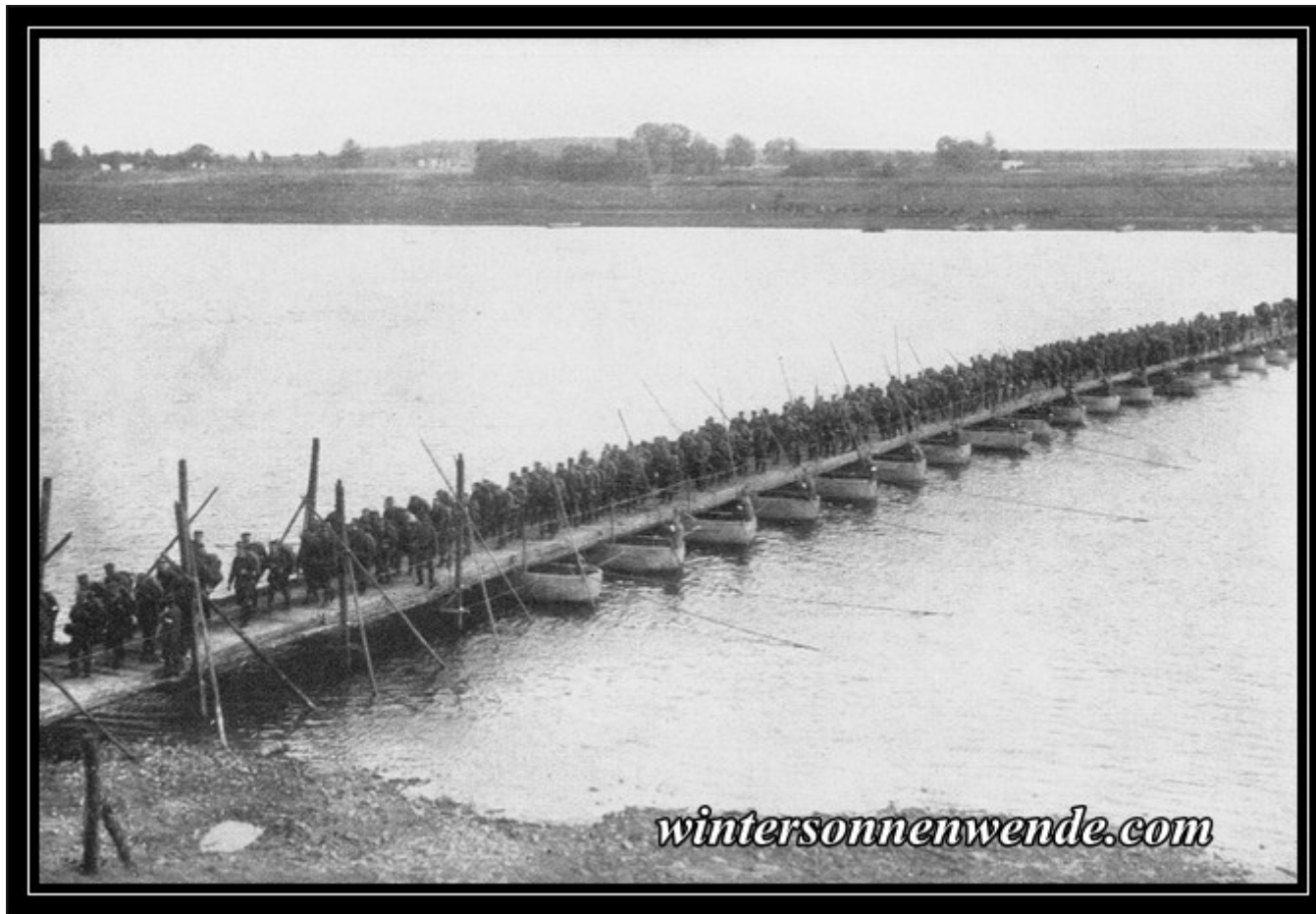
Deutsche Truppen überschreiten in Verfolgung der Russen auf einer Ponton-Notbrücke bei Warschau die Weichsel.
