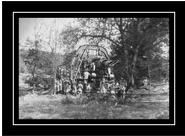
Ein 42-cm-Mörser wird mittels Hebekran aufmontiert und in Stellung gebracht.
