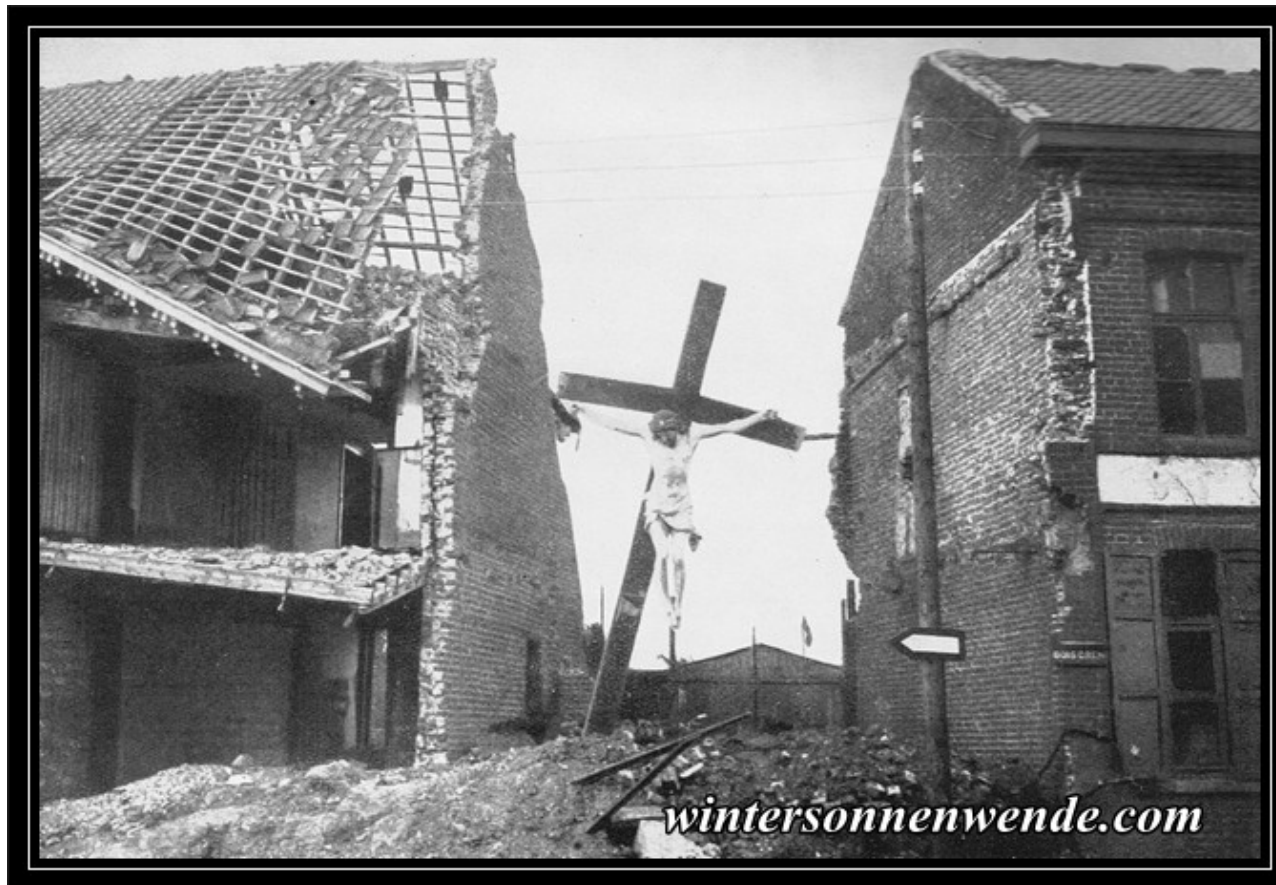
Während ganz Fleurbaix in Trümmern liegt, blieb der Christuskörper zwischen zwei am wenigsten beschädigten Häuser vollkommen unversehrt. Der Querbalken ist nur vom Luftdruck geknickt. Aufgenommen am 1. Juli 1918.
