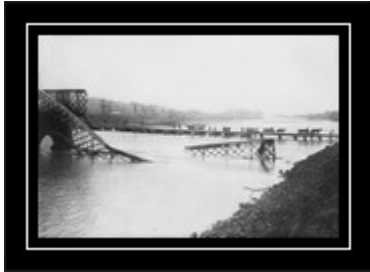
Von den Rumänen gesprengte Verkehrsbrücke in Rimik Valcea.
