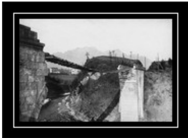
Gesprenge Eisenbahnbrücke über einen Nebenarm des Tagliamento.
