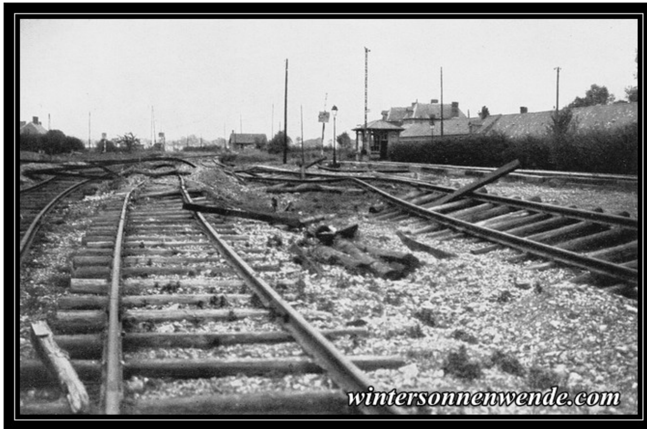
Vom Feinde beim Rückzug gesprengte Geleiseanlagen am Bahnhof Nesle westlich Ham.
