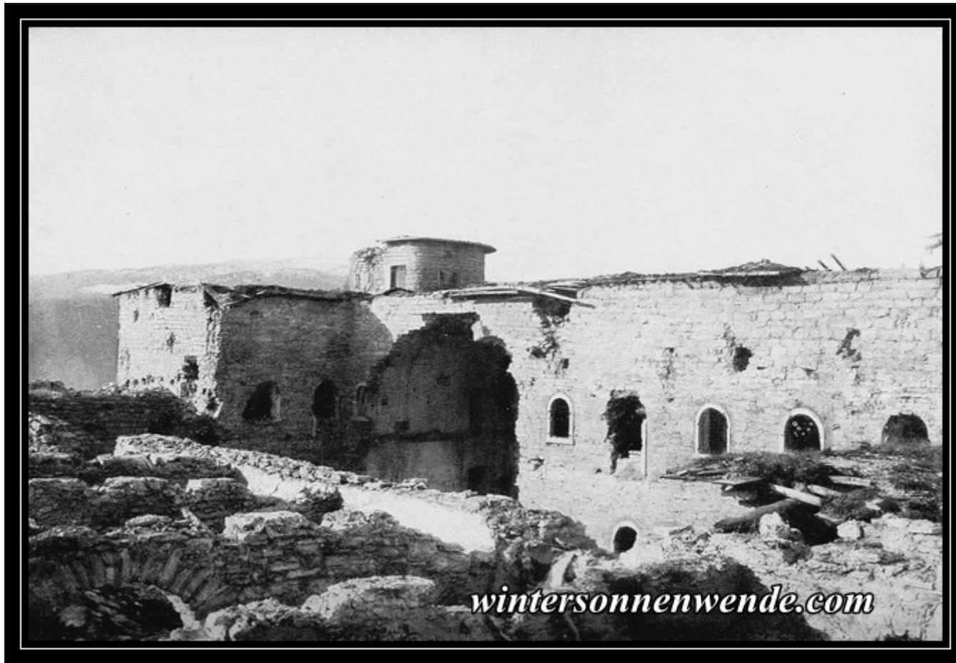
Das durch deutsche Artillerie zerstörte Fort 3 der russischen Festung Kowno , gefallen 18. August 1915.
