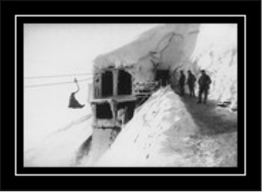
Durch die Truppen angelegte Drahtseilbahn in den Vogesen.
