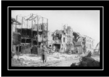
Die zerstörte große Zuckerfabrik bei Deulemont-Quesnoy.
