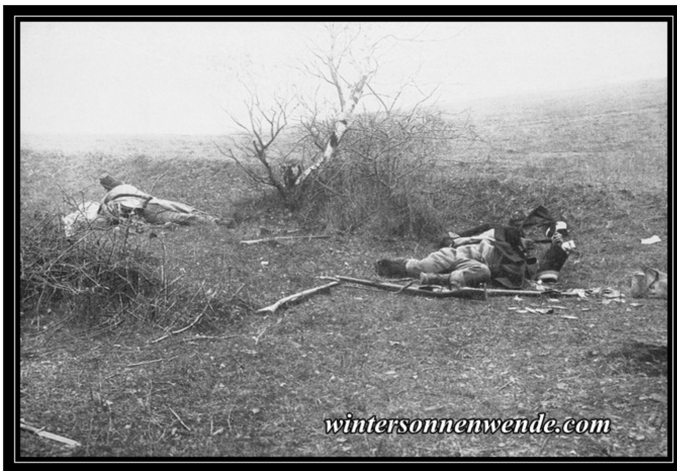
Gefallene Rumänen in einer Stellung bei Căineni.
