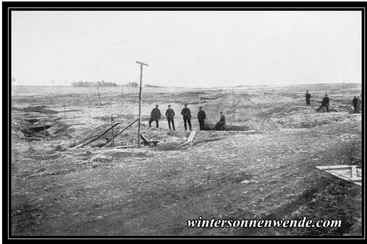
Vollkommen unter der Erde eingebaute und gegen Fliegersicht gut verdeckte Stellung einer 10-cm-Langrohrgeschütz-Batterie vor La Bassée. Aufnahme Februar 1918.
