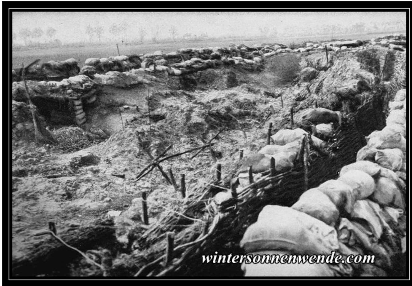
Erstürmte russische Stellungen, die in der Ebene mit Sandsäcken errichtet und gut ausgebaut waren.
