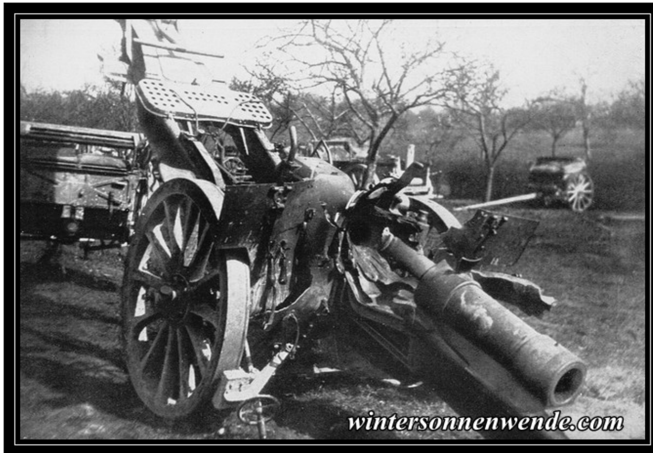
Ein schwerer Rohrkrepiierer. Das Geschöß kreperte im Augenblick des Abschusses infolge Konstruktionsfehler an der Zündung, wodurch das Rohr zerriß.
