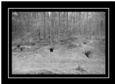
Russenunterstände im Wald bei Brzezany in Ostgalizien 1915.
