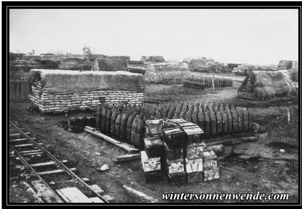
Unversehrt erbeutetes englisches Munitionslager bei Cambrai. Frühjahr 1918. Die mit Erdrich gefüllten Sackmauern dienen als Schutzwall gegen Explosionsübertragung auf die getrennt gelagerten Geschosse bei Beschießung oder Bombardierung des Lagers.
