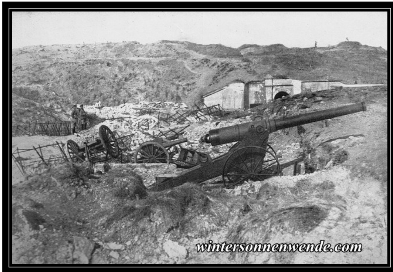
Alte gebrauchsunfähig gemachte Kanonen kleinen Kalibers im zerschossenen Fortgürtel von Manonviller .
