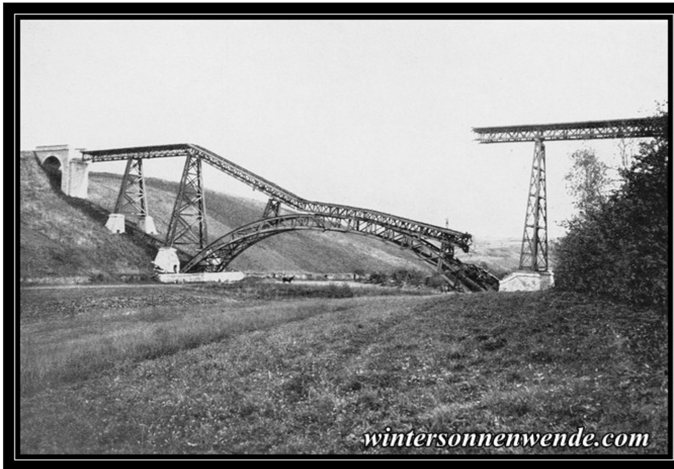
Eine der ersten von den Franzosen gesprengten Eisenbahnbrücken der Linie Thiaucourt–Toul, auf dem Vormarsch nach der Schlacht bei Metz . August 1914.
