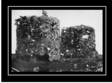
Die von Granatsplittern durchsiebten Gasbehälter einer Zuckerfabrik in Soissons.
