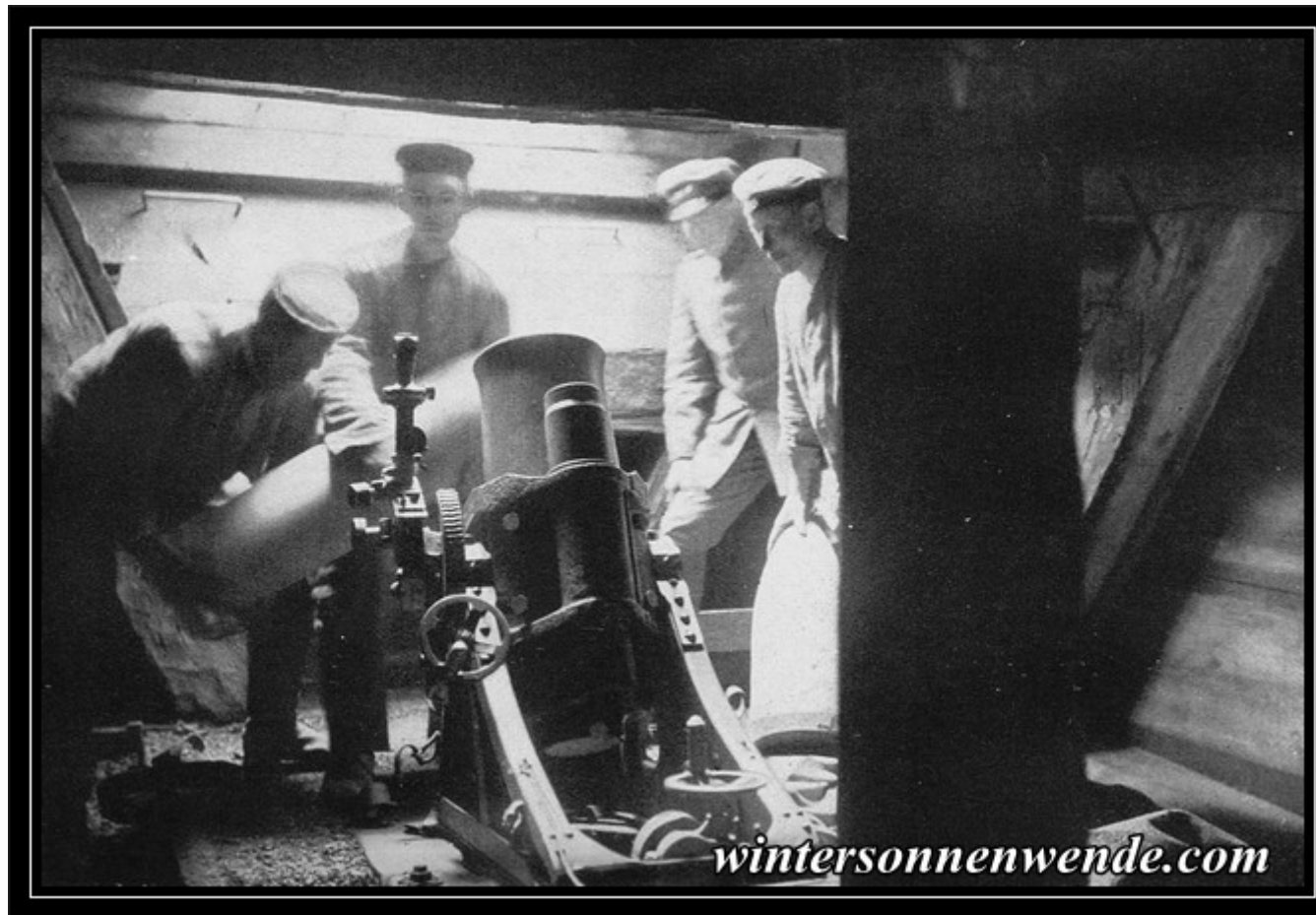
Schwerer deutscher Minenwerfer im Schützengraben auf dem Sudel (Vogesen). Aufnahme 1916. (Das Geschöß wog 2 Zentner 8 Pfund. Die Splitterwirkung erreichte eine Ausdehnung bis zu 1500 m.)
