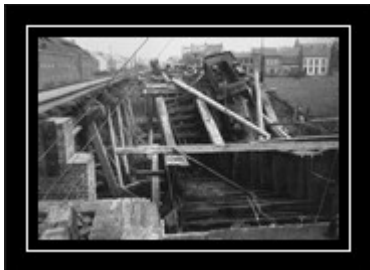
Zerstörte Eisenbahnbrücke bei Jeumont-Maubeuge.
