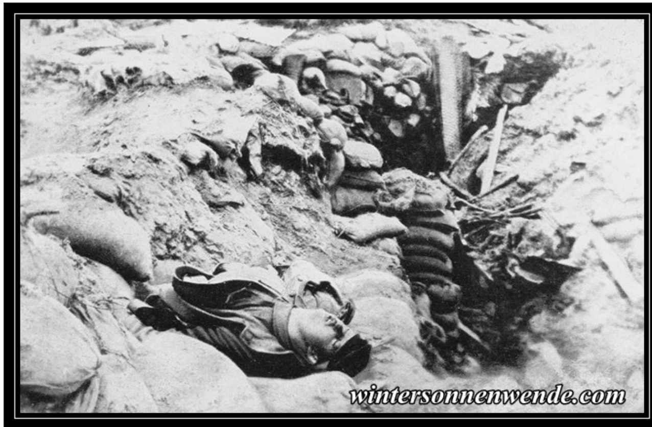
Wirkung eines schweren 30-cm-Granateinschlages (bei Arras 1917). Die Grabenbesatzung wurde getötet und verschüttet; nur ein Mann blieb mit dem Oberkörper sichtbar.
