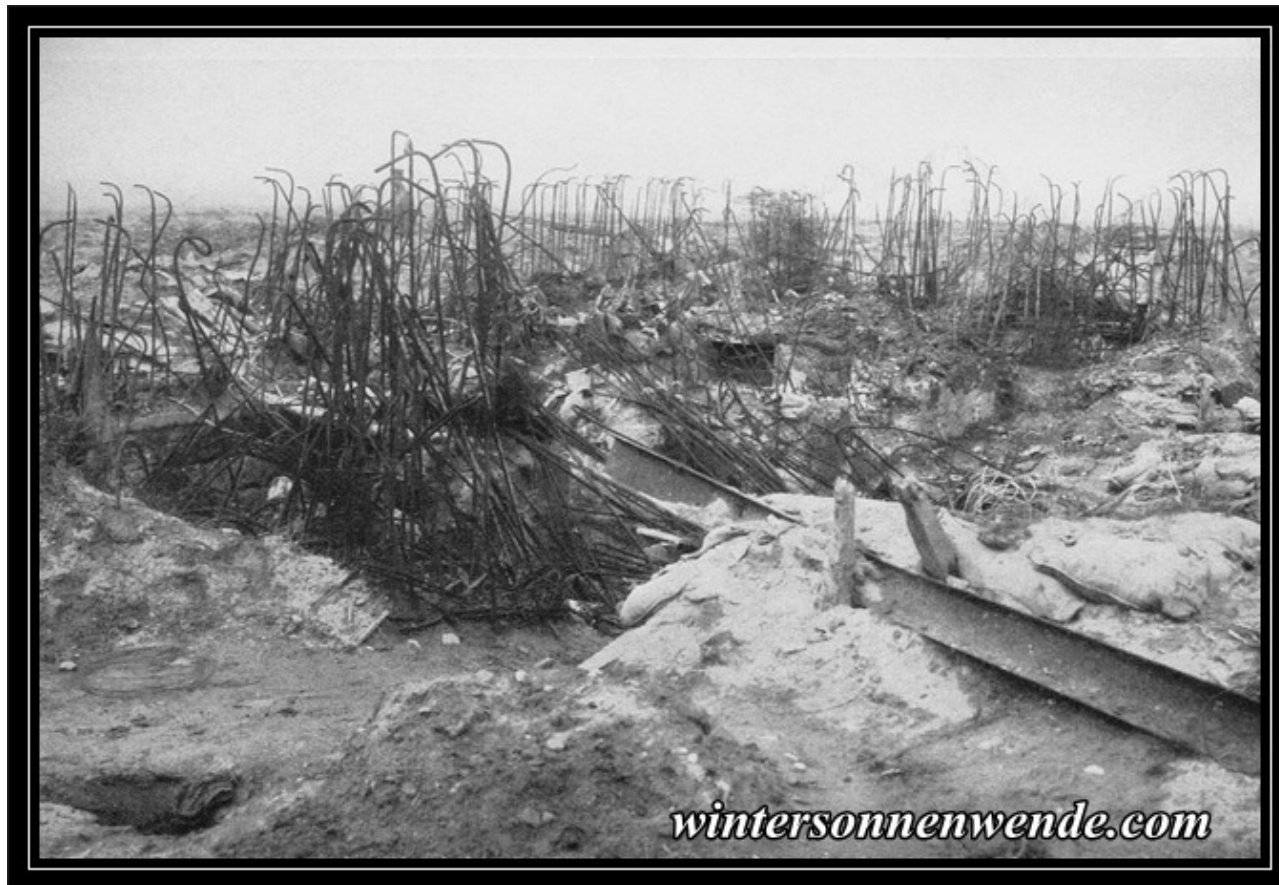
Durch deutsches Feuer zertrommelter, stark betonierte gewesener englischer Stützpunkt. Nachdem die Betonbruchstücke in die Luft geflogen, blieb nur mehr ein Wald von Eisenstäben übrig.
