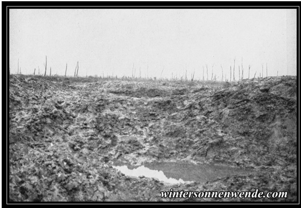
Dieselbe Stelle [wie auf dem vorhergehenden Bild ], an der einige Monate früher die französische Ortschaft Serre stand. Das Bild zeigt, was schwere Granaten in kurzer Zeit auszurichten vermögen. Hinter den Baumgruppen die neuen Stellungen. Aufnahme 9. Februar 1917.
