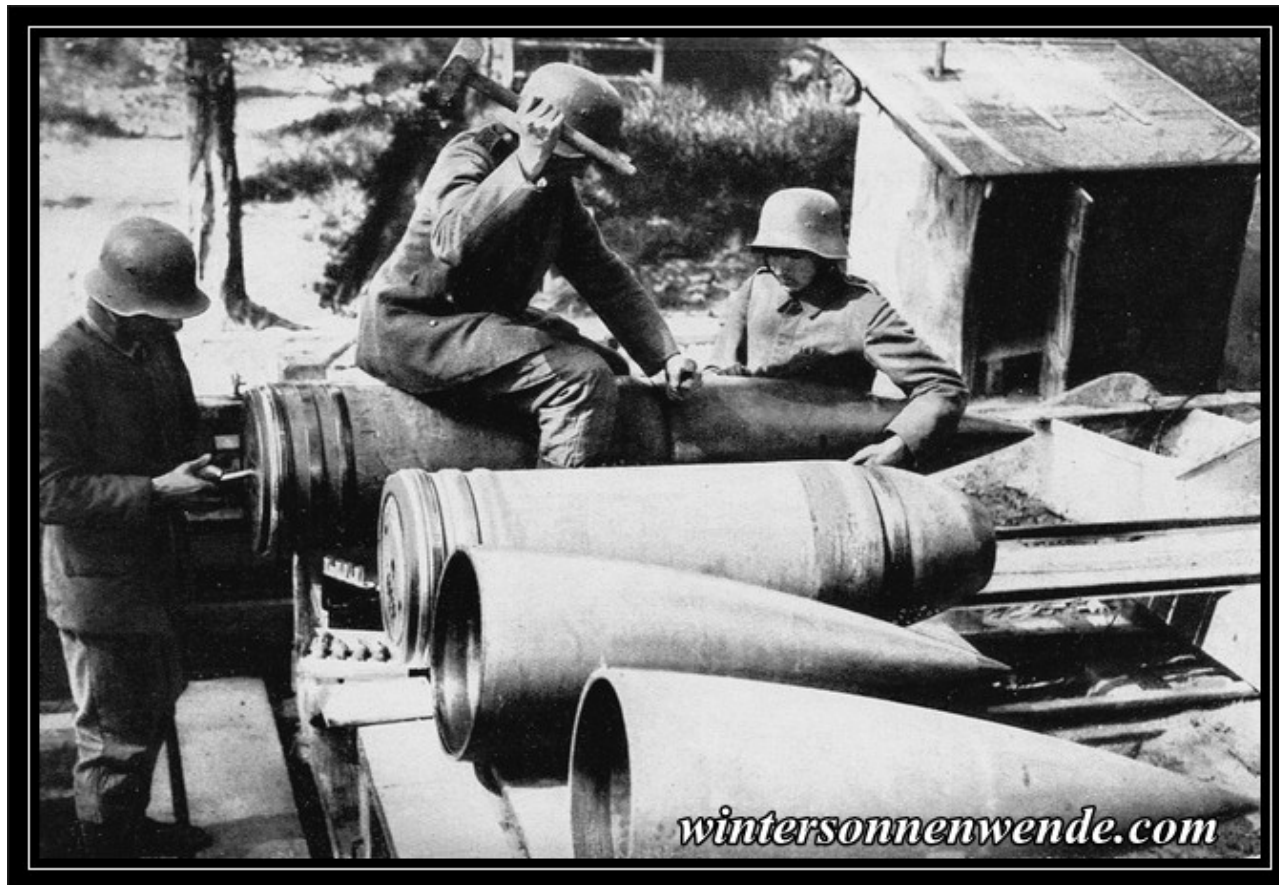
Montieren der 18 Zentner schweren Riesengeschosse zur 38-cm-Schnelladekanone.
