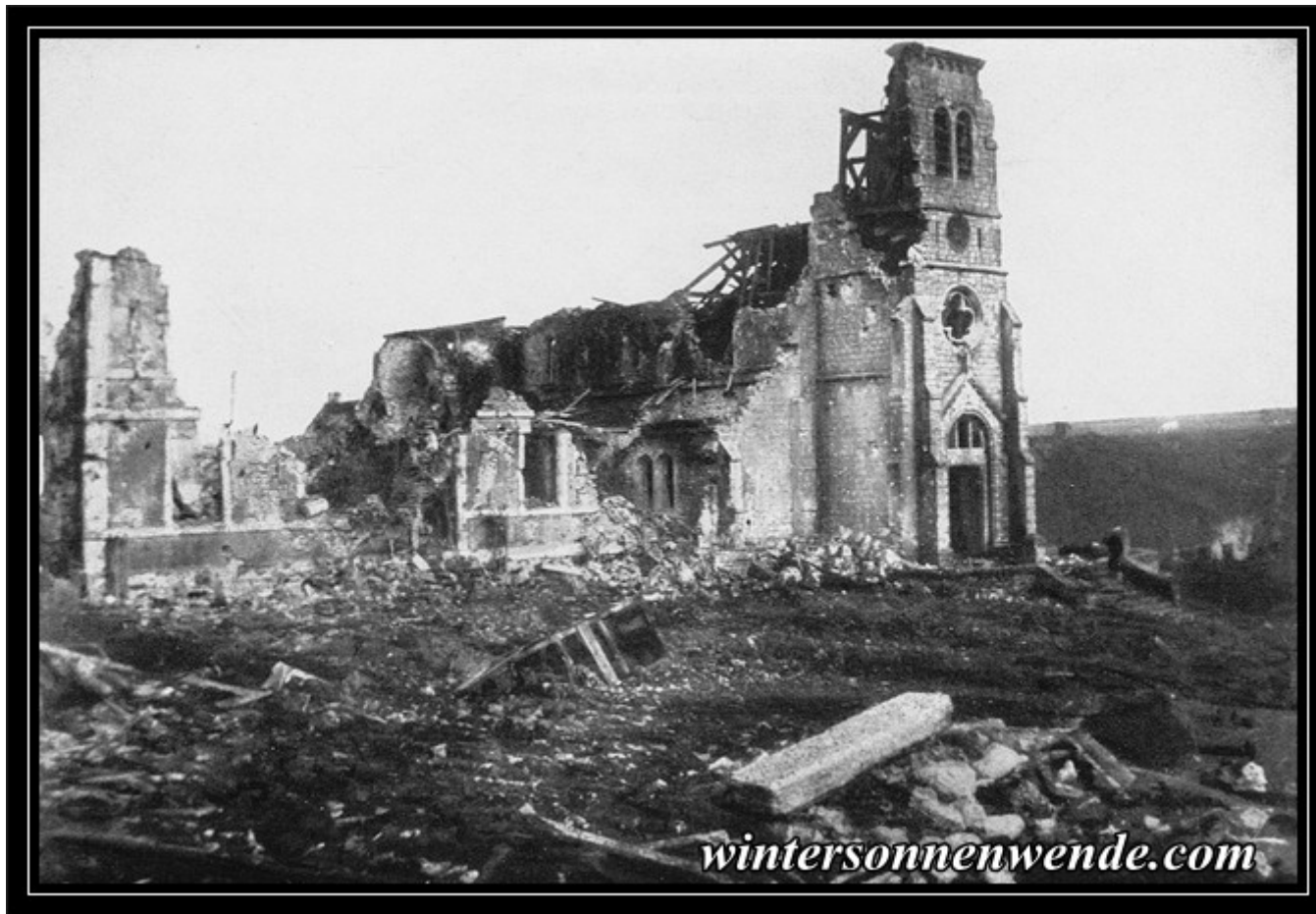
Die stark zerschossene Kirche des Ortes Forges bei Verdun.
