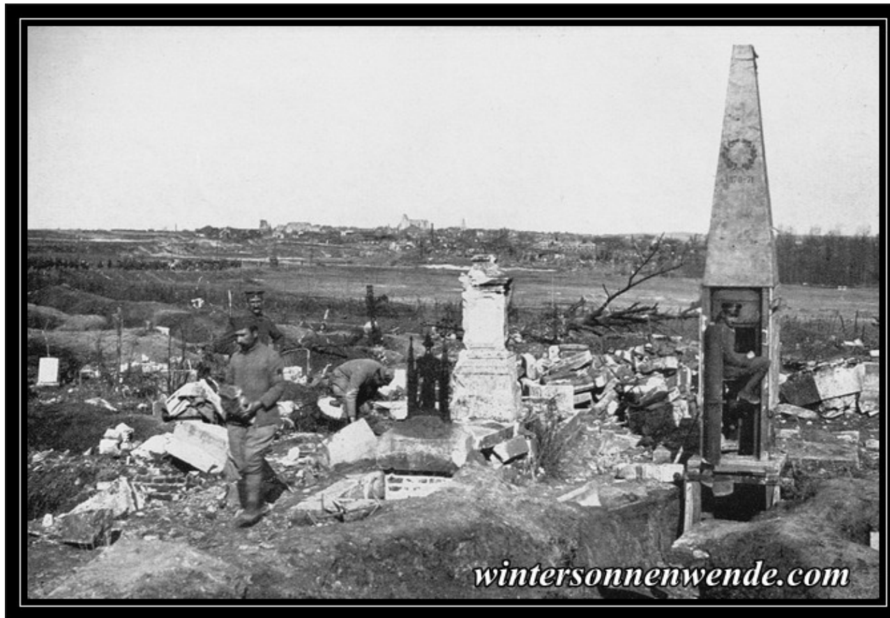
Eroberte englische Stellungen, im Hintergrund St. Quentin, davor die berühmte deutsche Siegfriedstellung. Ein im Friedhof eingebauter gepanzerter englischer Beobachtungsstand, der durch seine Leinwandattrappe das Aussehen eines friedlichen Denkmals für Gefallene von 1870/71 erhielt, bot den Engländern Einsicht in die deutschen Stellungen. Der Beobachter konnte bis in die Spitze dieses Scheindenkmals hochsteigen.
