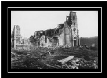
Die stark zerschossene Kirche des Ortes Forges bei Verdun.
