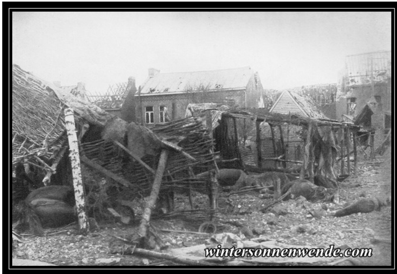
Durch Artilleriefeuer zerstörte Pferdebaracken im Städtchen Estaires nach der Erstürmung am 15. April 1918.
