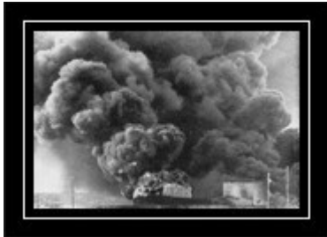
Brand zahlreicher Petroleum-Tanks am Hafen von Constanza.
