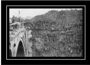
Eine englische Brigade an einer eroberten Kanalbrücke.
