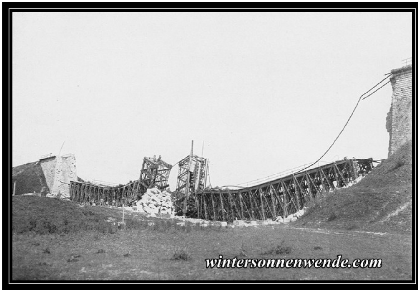
Die von den Russen gesprengte Eisenbahnbrücke bei Pluhów (Ostgalizien) 1915.
