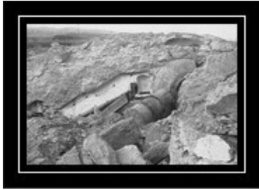
Zerstörter Panzerturm des Fort Loncin in der Festung Lüttich.
