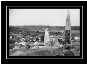
Ein im Friedhof eingebauter gepanzerter englischer Beobachtungsstand, der durch eine Leinwandattrappe das Aussehen eines friedlichen Denkmals für Gefallene erhielt.
