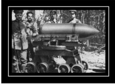
Die "Dicke Berta" wird angefahren.
