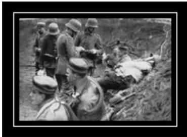
Anlegen der ersten Notverbände auf dem Truppenverbandplatz.
