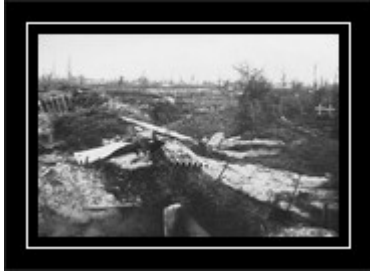
Nach dem Sturm bei Le Mesnil.
