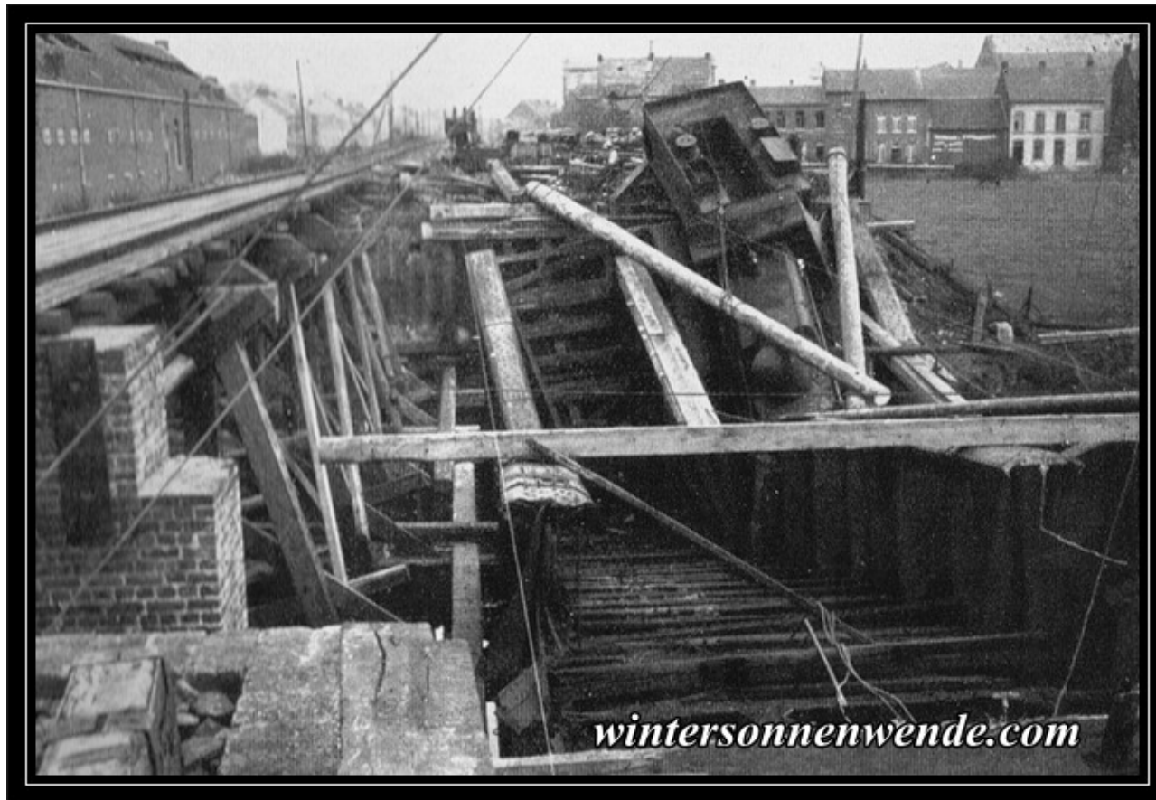
Von den Franzosen und Belgiern zerstörte Eisenbahnbrücke bei Jeumont-Maubeuge.
