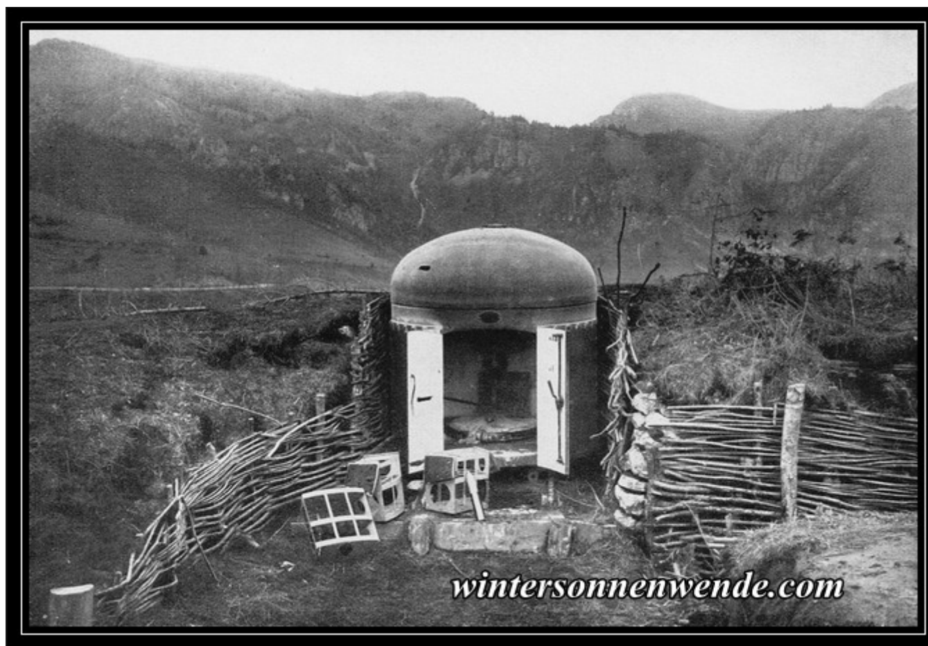
Ein am Törzburger Paß eingebauter rumänischer Panzerturm mit Maschinengewehr im Innern.
