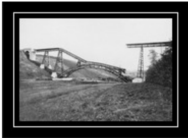
Eine der ersten von den Franzosen gesprengten Eisenbahnbrücken.
