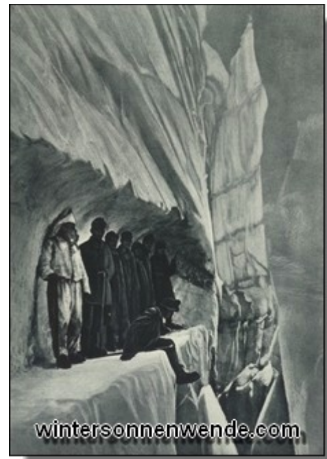
Abb. 4: Vortreiben eines Galerie-Eisstollens in einer Gletscherspalte (Marmolata).
