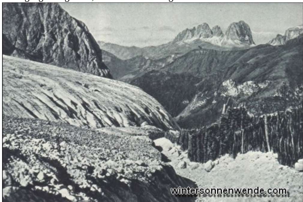
Abb. 13: Stolleneingang, der durch die Schneeschmelze im Sommer einige Meter hoch im Gletscherabbruch liegt. Rechts mit Flechtweg maskierter Zugangsweg (Marmolata). Im Hintergrunde die Langkofelgruppe.
