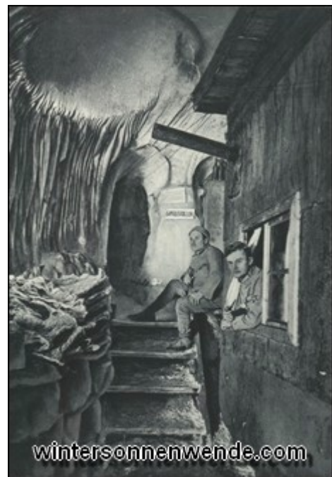
Abb. 24: Baracke im Bauch des Gletschers (Hohe Schneid, 3431 m. Vgl. Abb. 23 . Durch die Wärme des Rauches aus dem Abzug schmilzt das Eis der Decke.
