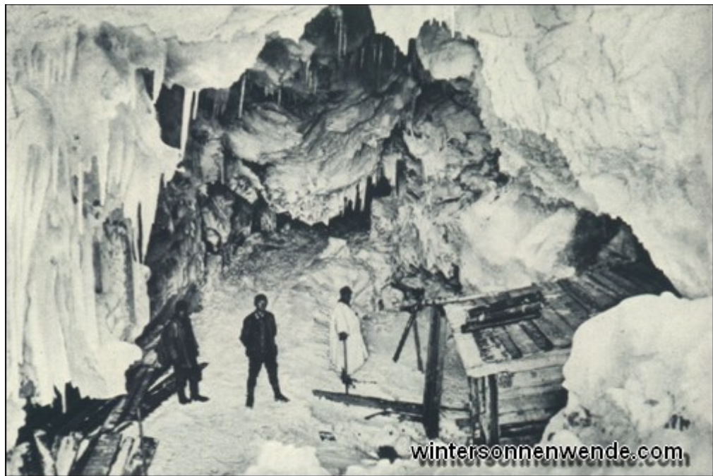
Abb. 16: Bau einer Baracke im Gletschertor (Marmolata).
