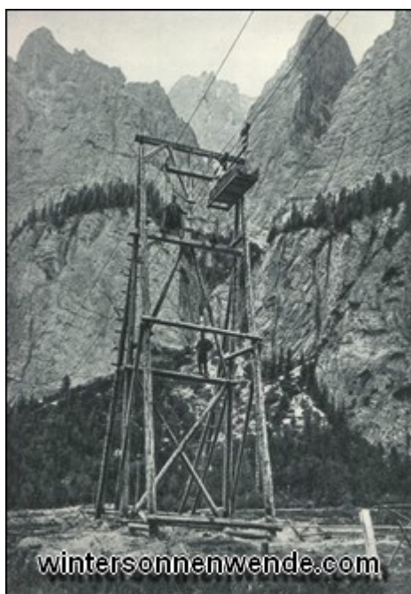
Abb. 74: Stütze der Seilbahn auf die Fanesscharte, 2657 m. Rückwärts die Fanis-Dolomiten.
