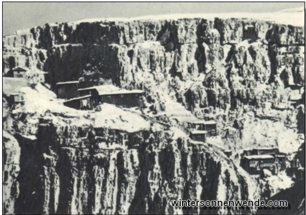
Abb. 36: Baracken und Seilbahnstation eines österreichischen Reservelagers in der Felsenwand des Monte Piano, 2324 m (Dolomiten).
