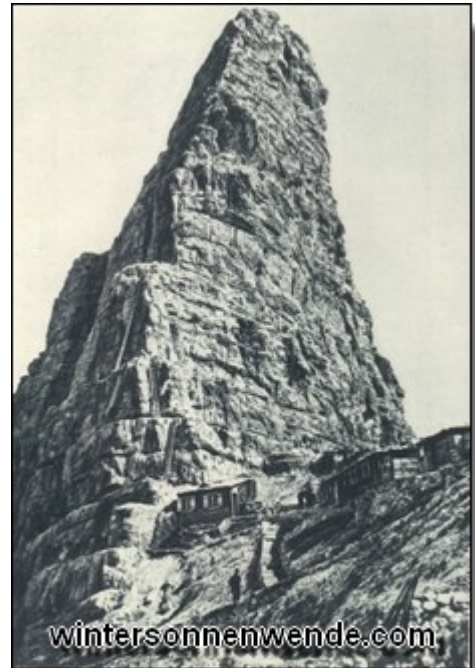
Abb. 39: Toblinger Knoten (vgl. Abb. 38 ) mit Leiteraufstieg zum Artilleriebeobachtungsstand auf seinem Gipfel, zu dem auch eine kleine Seilbahn führte.
