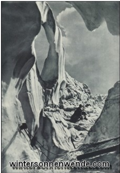
Abb. 7: Ausgang eines Gletscherstollens. Links Panzerkabel für Telefon und elektrische Kraft.
