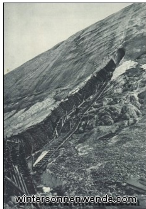
Abb.11: Stolleneingang in den Gletscher. Der vom Feind eingesehene Zugang ist durch einen Flechtzaun maskiert.
