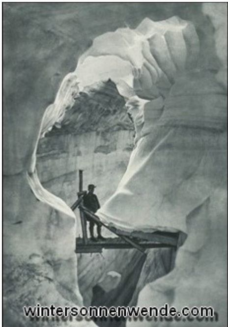
Abb. 9: Stollenbrücke über eine Gletscherspalte. Der Eingang zum Stollen ist zusammengebrochen (Marmolata).
