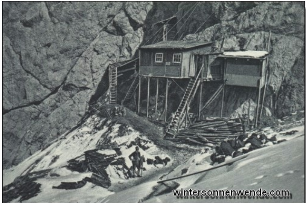
Abb. 19: Unterstände, die wegen der winterlichen Schneemassen auf hohen Pfählen erbaut und mit Drahtseilen an den Felsen verankert sind (Marmolata).
