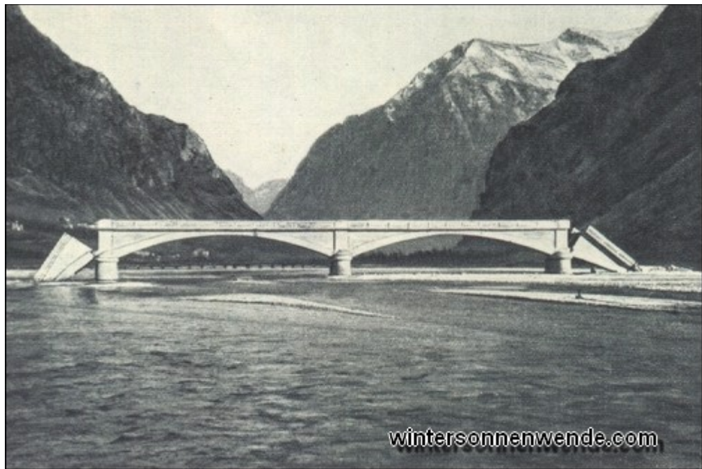
Abb. 84: Von den Italienern beim Rückzug gesprengte Brücke im Piavetal.
