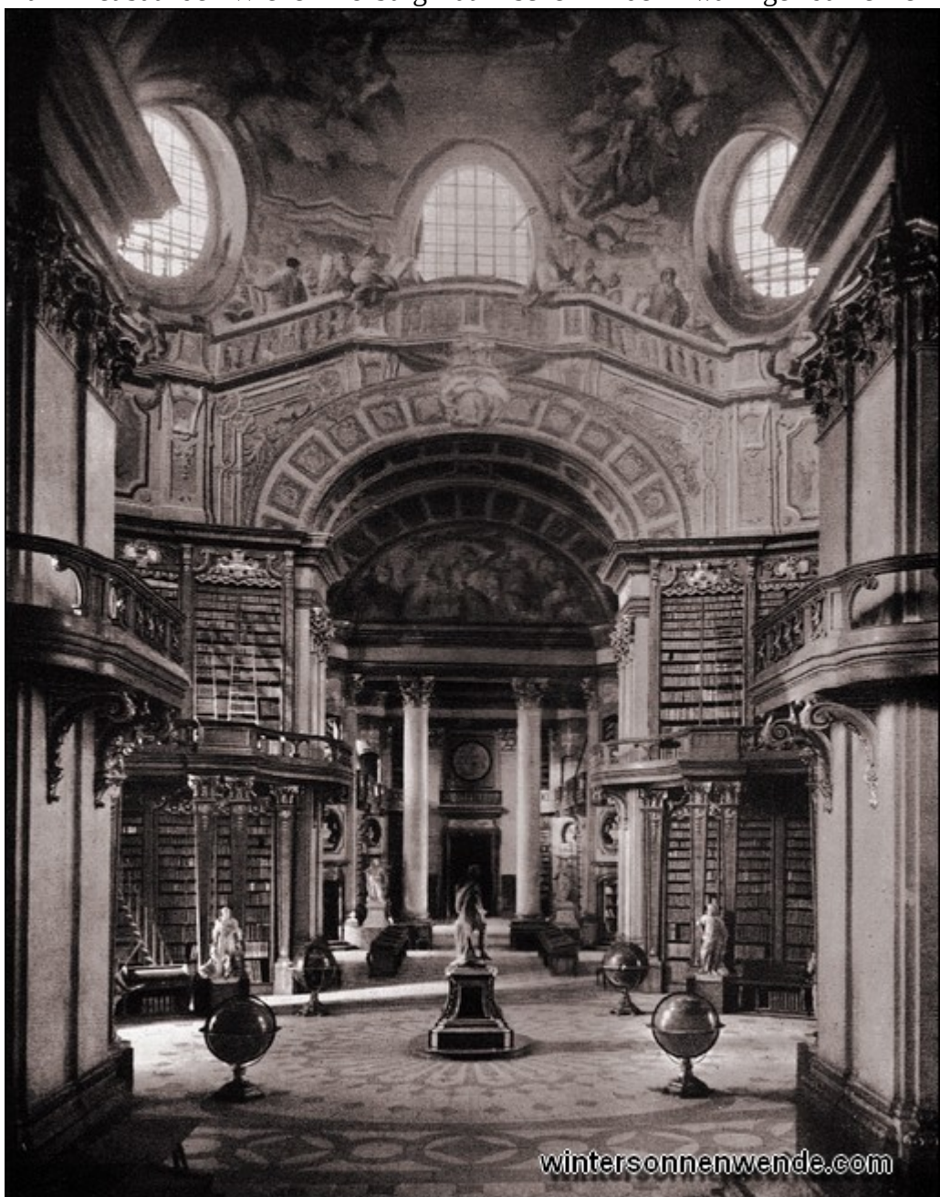
[72b] Fischer von Erlach: Hofbibliothek in Wien , erbaut 1722–1726.
