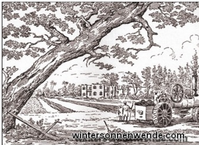
[413] " Mein Haus in Schubra ", nach einem Aquarell von Max Eyth. [Bildquelle: Gerda Becker, Berlin.]
