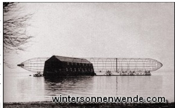
[264c] Das Gerippe des Luftschiffes LZ5 vor der schwimmenden Ballonhalle auf dem Bodensee bei Friedrichshafen, 1908.
