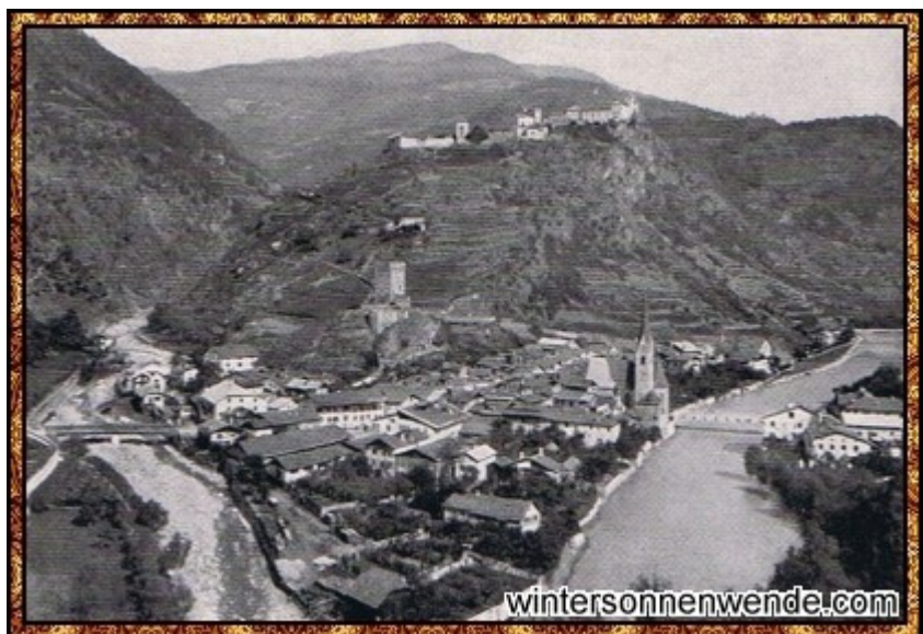
[236b] Klausen südlich des Brenner.
