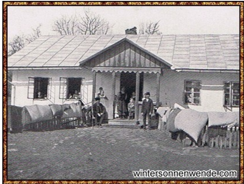
[92b] Deutsches Wohnhaus in Nadworna in Galizien.
