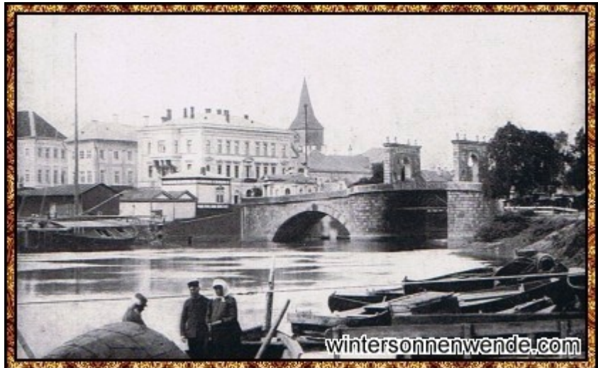
[272b] Dorpat, Embachbrücke.
