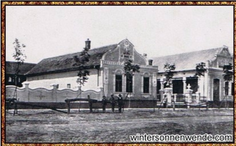
Nr. 185: Bauernhäuser in Alexanderhausen, Banat
