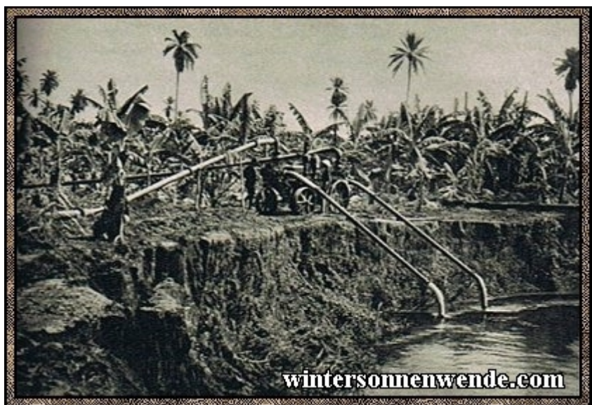
Fahrbare Pumpenanlagen bewässern in Kamerun die Bananenfelder.
