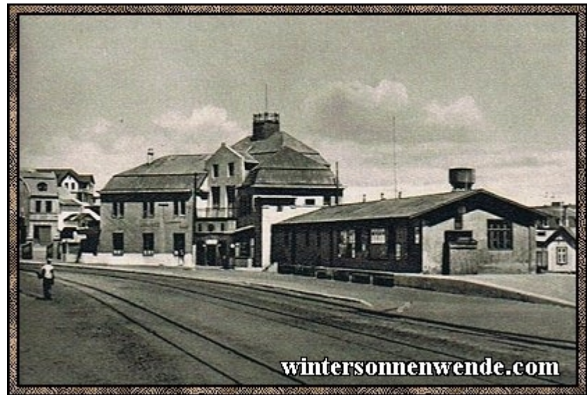
Der Bahnhof in Lüderitzbucht.
