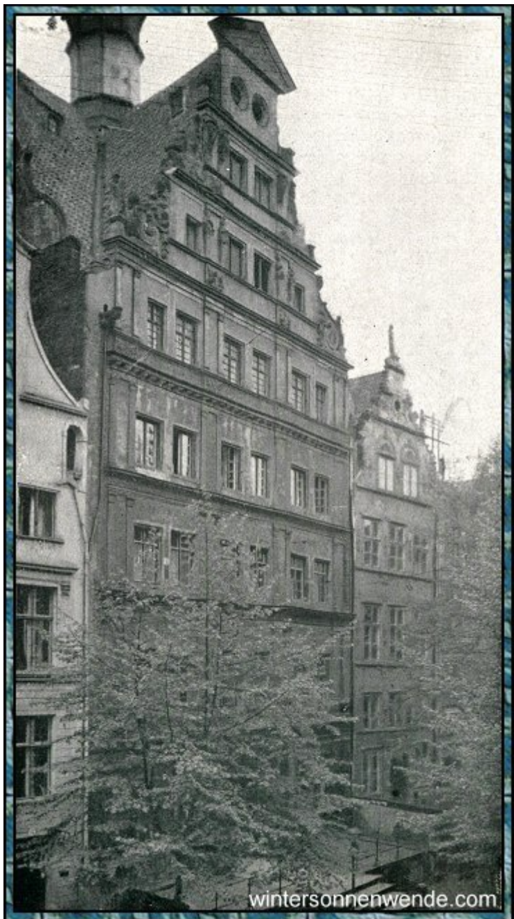
Englisches Haus Brotbänkengasse Nr. 16. (Erbaut 1570.)
