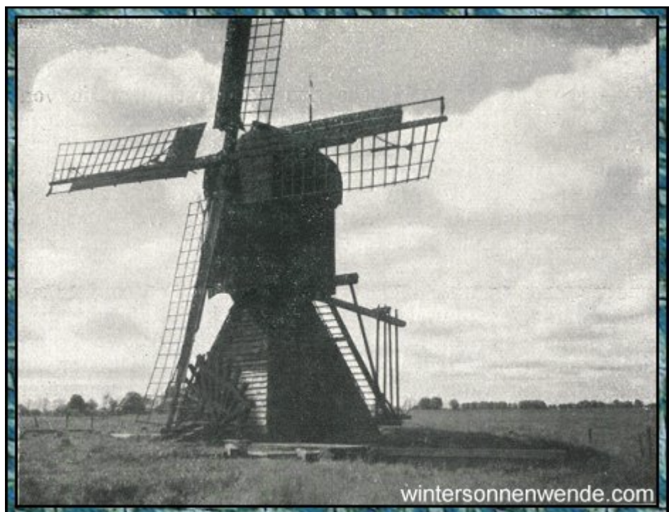
Charakteristisches Wasserschöpfwerk aus der Deutschordenszeit im Danziger Werder
