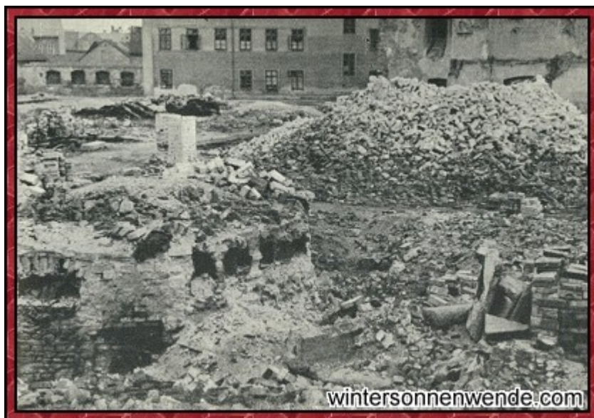
Gesprengte Porzellanöfen einer Porzellanfabrik bei Karlsbad. Die sudetendeutschen Porzellanfabriken führten über 80 v. H. der erzeugten Mengen bis zum Jahre 1929 aus. Durch die falsche Handelspolitik des Staates ging nach 1929 ein Auslandsmarkt nach dem anderen verloren. Das Ergebnis ist furchtbar. Die Fabriken verfallen oder werden im Exekutionswege verschleudert.
